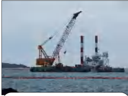
工事強行の現実に改めて“怒”
